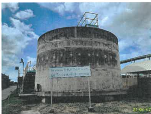
บ่อเพิ่มตะกอนเข้มข้น
